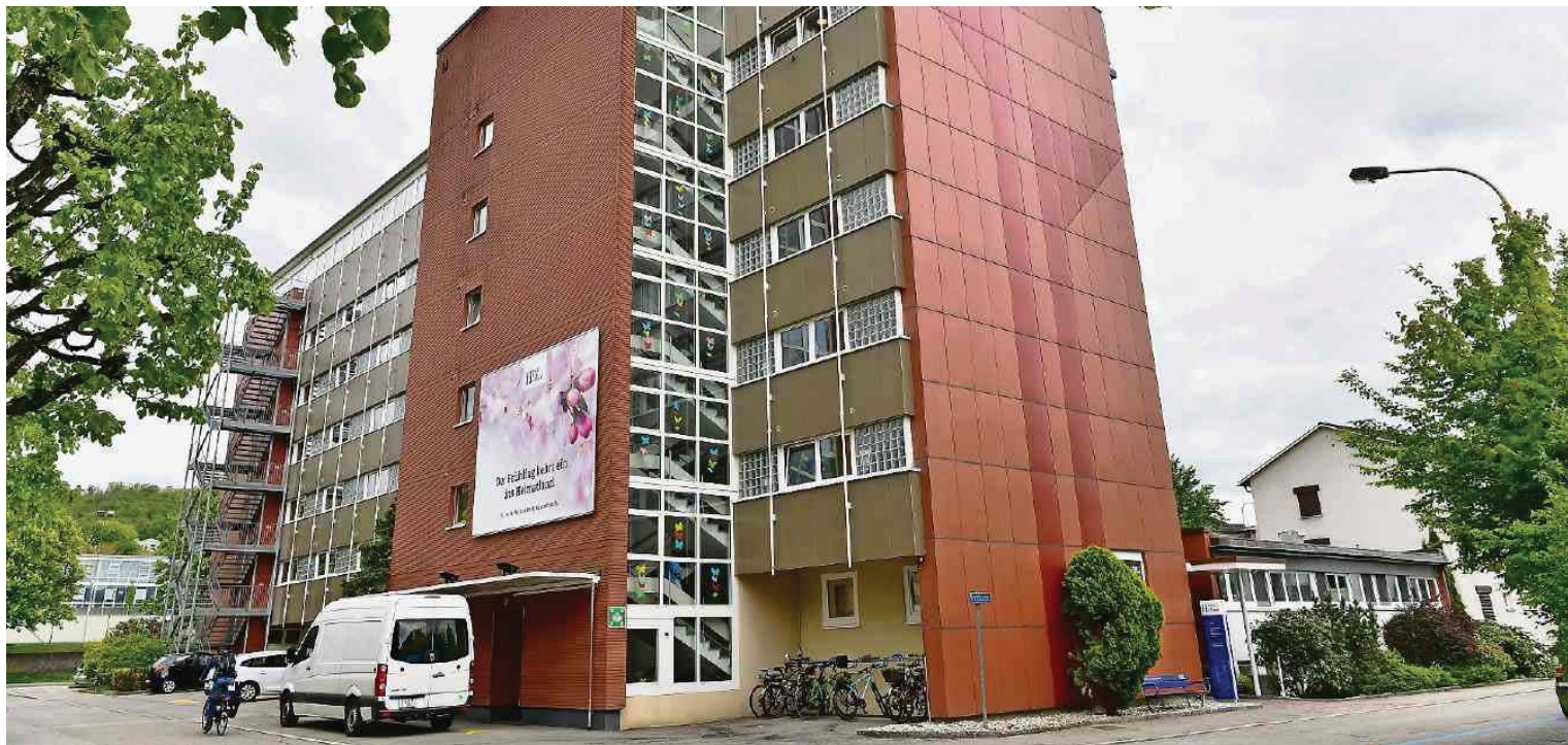
Im bisherigen Alters- und Pflegeheim Haus zur Heimat neben dem Vögelipark sollen 40 Alterswohnungen mit Spitexdienstleistungen entstehen.
